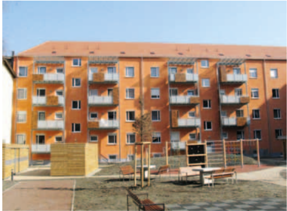
Modernisierung (einschl. Außenanlagen) Herbartstraße 9-11
