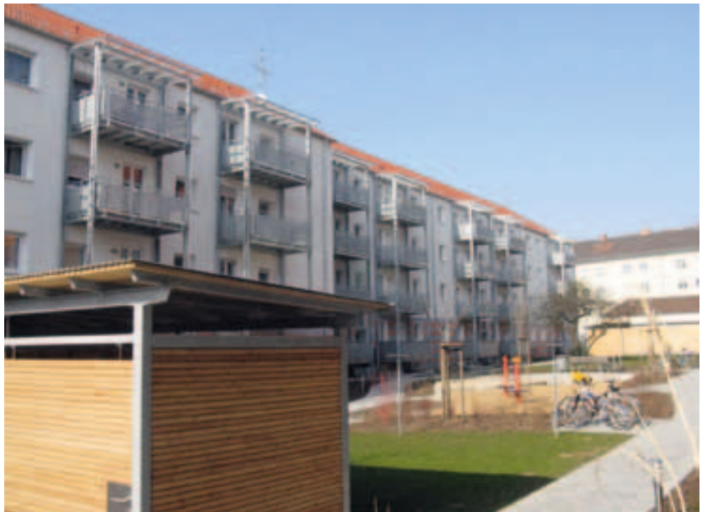
Modernisierung Nordostbahnhof (einschl. Außenanlagen)
