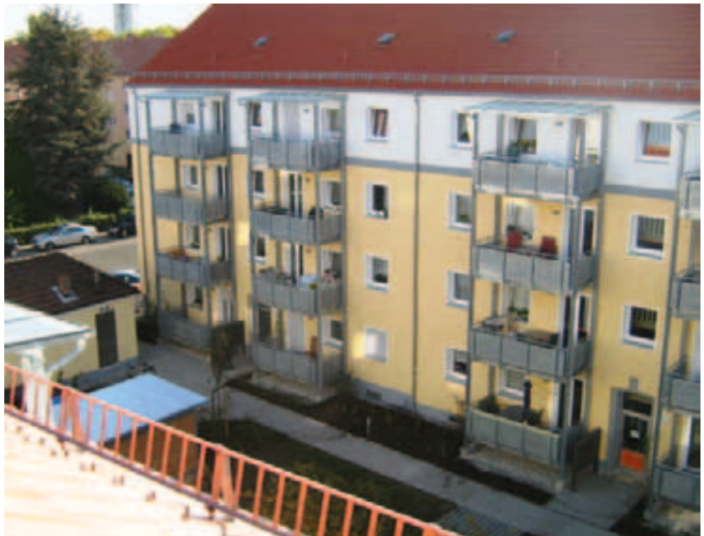
Modernisierung Nordostbahnhof (einschl. Außenanlagen)
