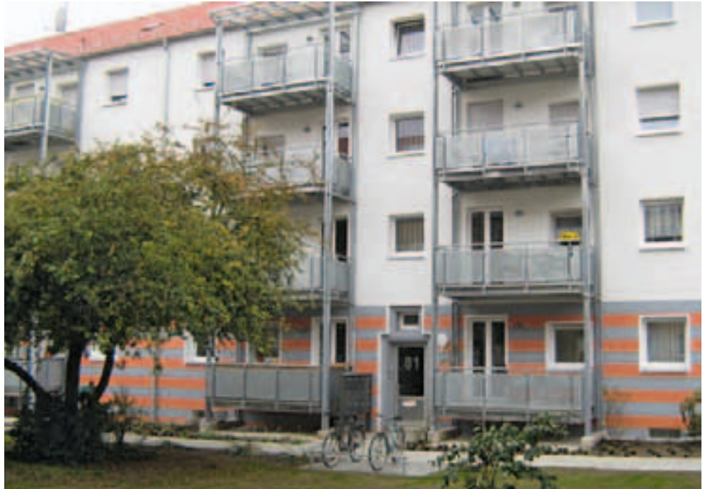
Modernisierung Nordostbahnhof (einschl. Außenanlagen)
