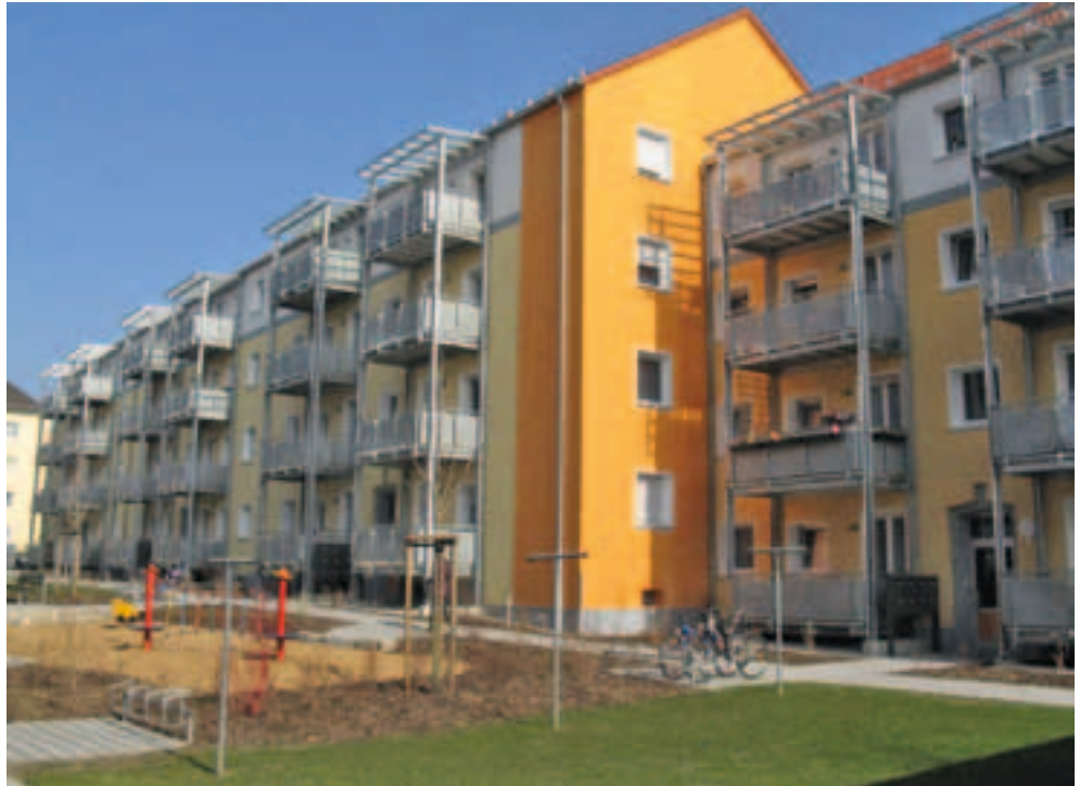
Modernisierung Nordostbahnhof (einschl. Außenanlagen)
