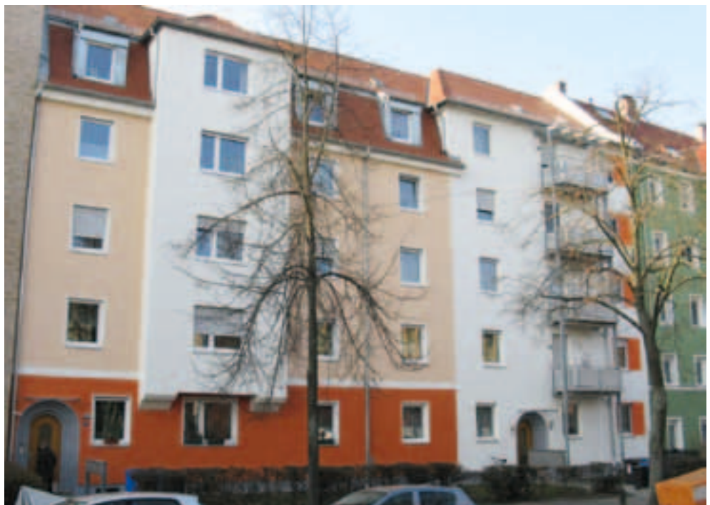
Modernisierung Schönweißstraße 10-12 (Straßenansicht)
