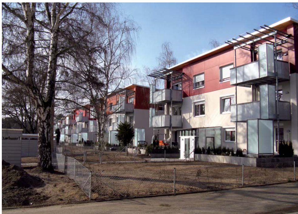
Modernisierung Semmelweisstraße 9-13 (mit Aufstockung)
