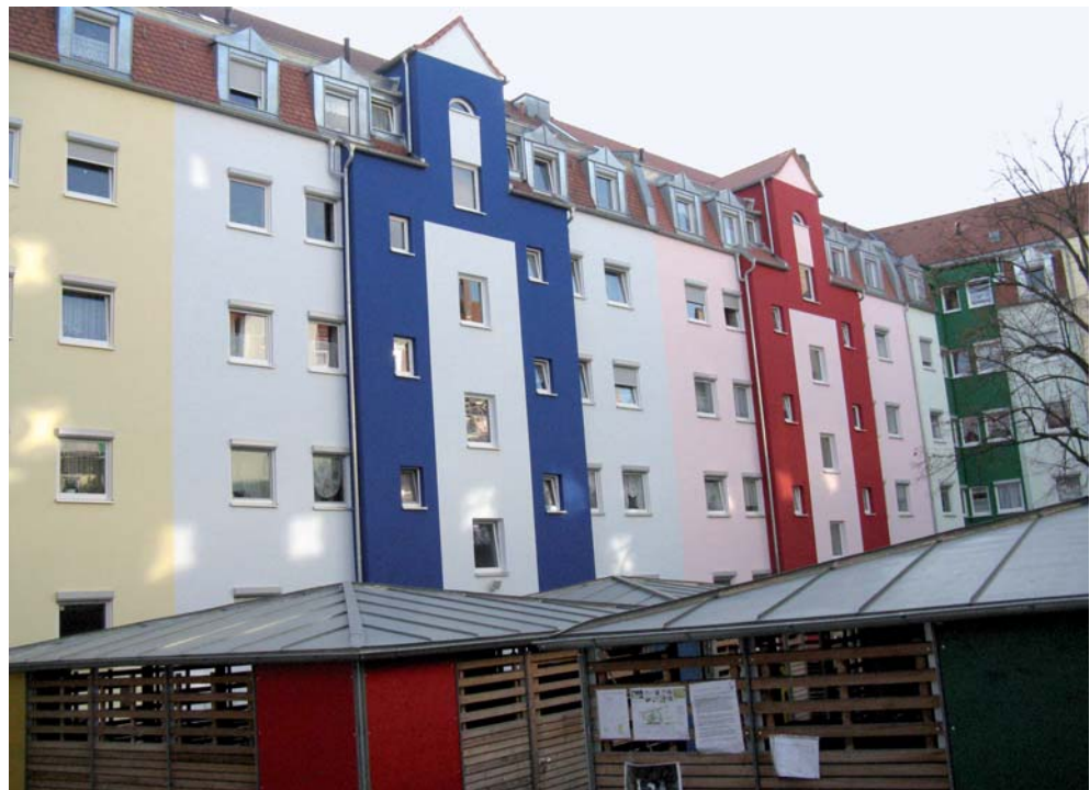
Modernisierung Muggenhofer Straße 46-50 (Innenhof)
