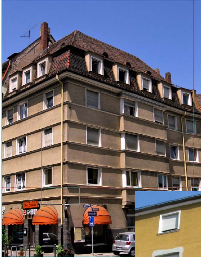
(Kirchenstraße 25 vor Modernisierung)
