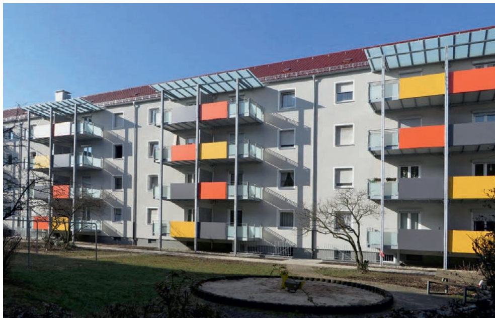
(Modernisierung Herbartstraße 21-27, Balkone)
