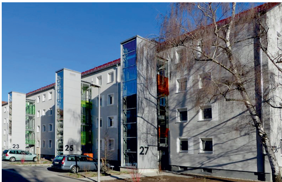
(Modernisierung Herbartstraße 21-27, Aufzugsanbauten)
