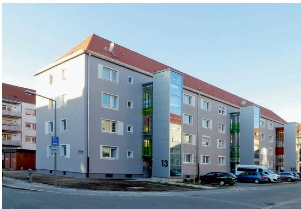
(Modernisierung Herbartstraße 13-17, Aufzugsanbauten)
