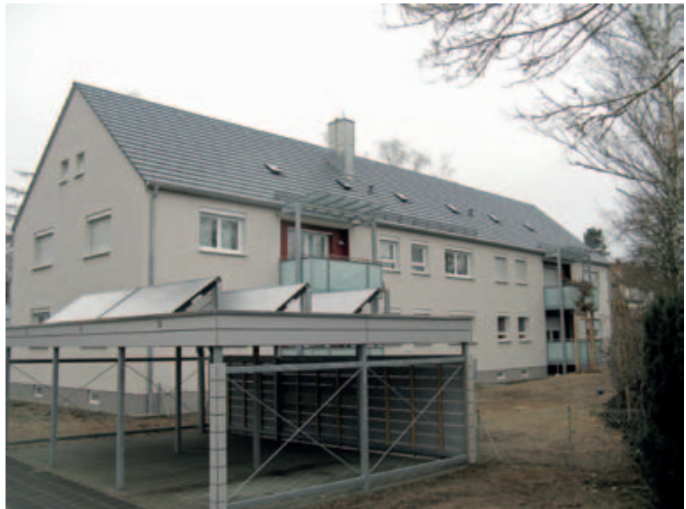
Modernisierung Semmelweisstraße 15 - 17 (einschl. Außenanlagen); Rückansicht
