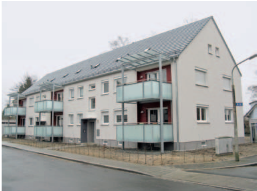
Modernisierung Semmelweisstraße 15 - 17 (einschl. Außenanlagen); Straßenansicht
