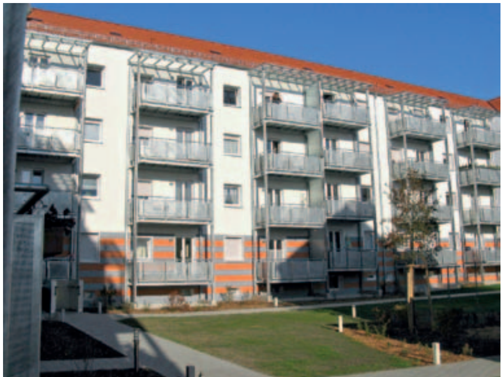
Energetische Sanierung (einschl. Außenanlagen) Nordostbahnhof
