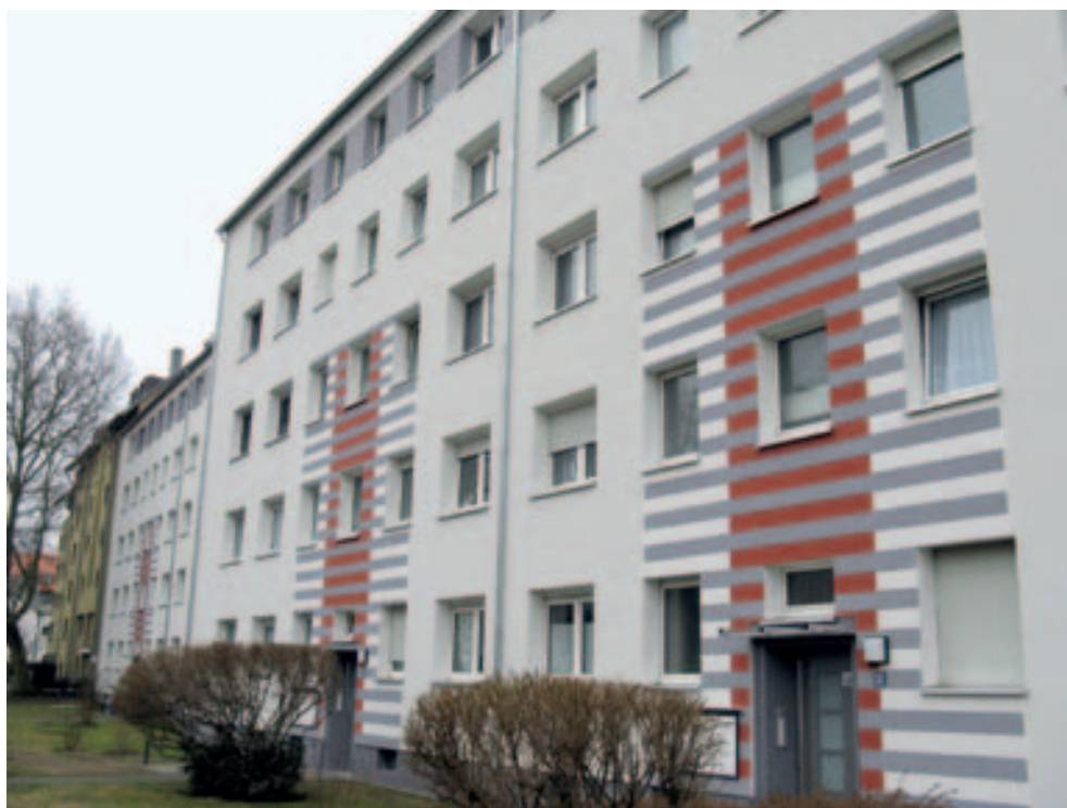
Modernisierung Herbartstraße 32 - 38 (Straßenansicht)
