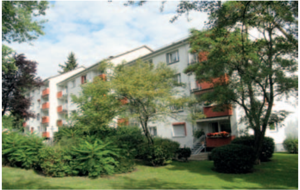
Energetische Modernisierung Hardenbergstraße 68 - 72 (einschl. Außenanlagen)
