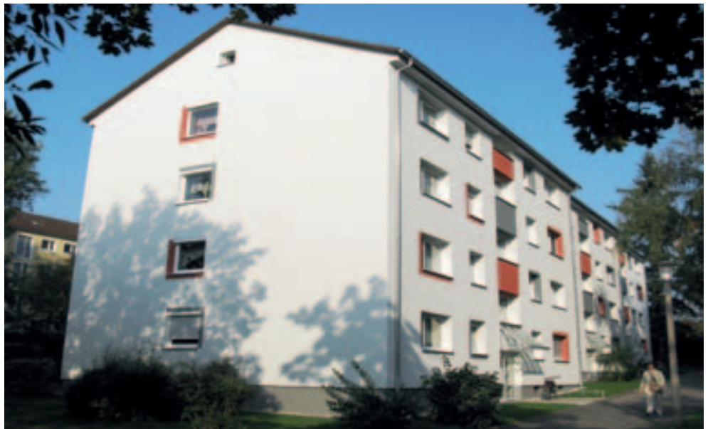
Energetische Modernisierung Hardenbergstraße 68 - 72 (einschl. Außenanlagen)
